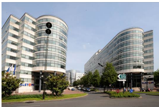
Siège d'Alstom, quartier du Front de Seine
