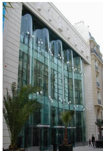
Façade du conservatoire Maurice Ravel, donnant sur la rue Gabriel Péri
